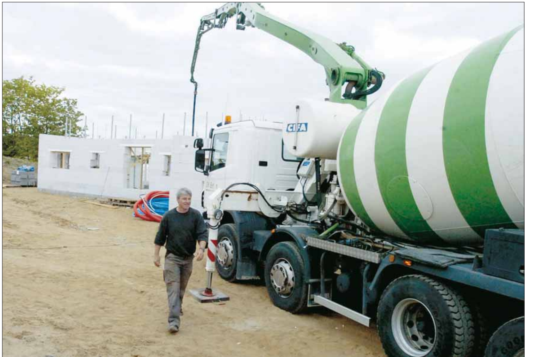
I sidste uge blev der fyldt beton i hulrummet mellem de lette flamingo-klodser, der udgør ydermurene i det meget anderledes parcelhus på Finsensvej 16 i Taulov. – Foto: Peter Honoré
